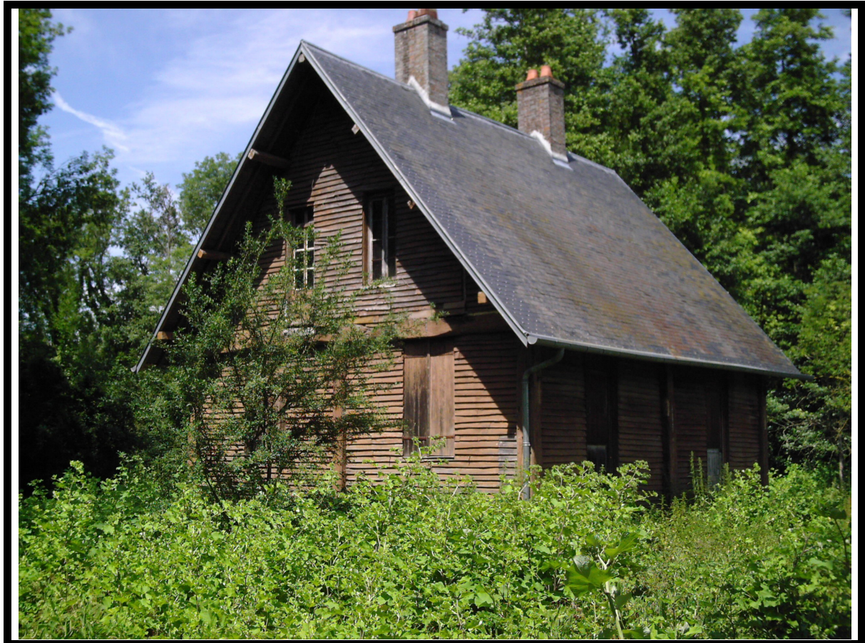
Photo n° 2 : Habitation où est installé le matériel d'enregistrement
